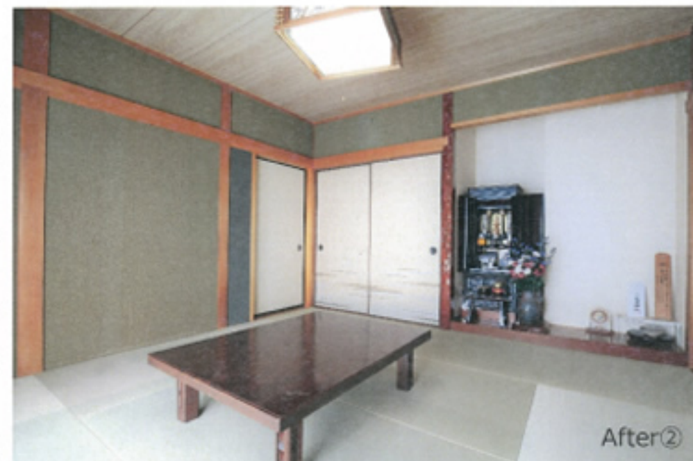
床の間を改修し仏壇が収まるようになった和室は、老朽化していた畳を入れ替え、南面の掃出窓に障子の代わりに内窓を設けた。
