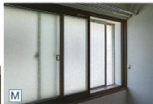
↑ もともののアルミサッシの内側に内窓を付け、二重窓に。窓の断熱性、機密性が高まり、住みやすさもアップしました。
