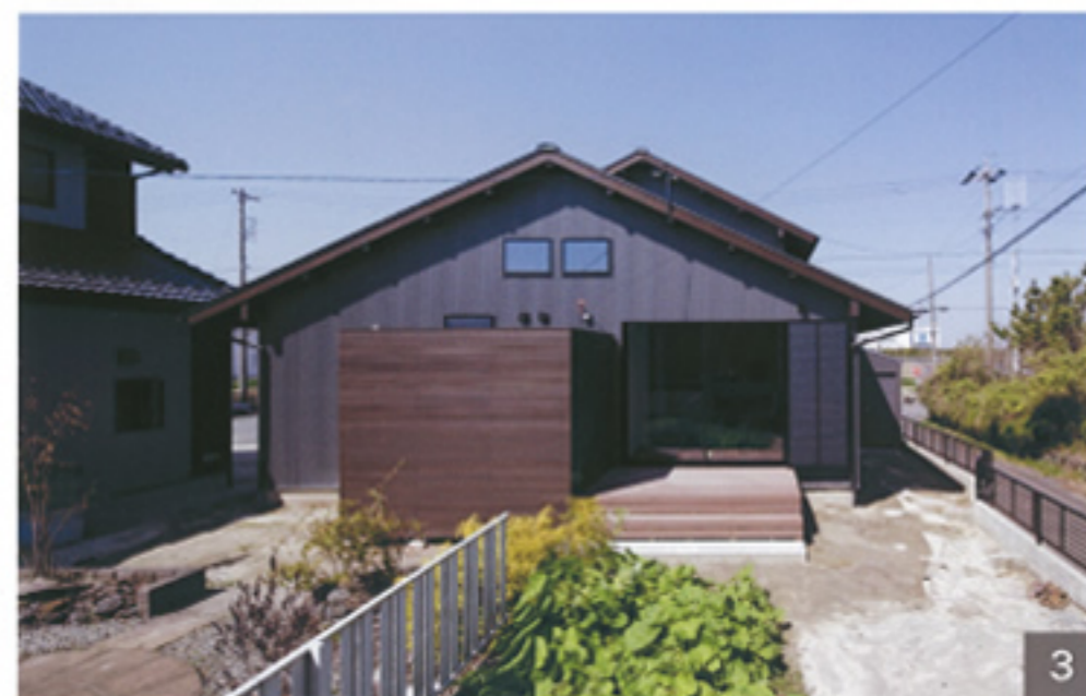
↑ 母屋の東面 LDから東の庭にウッドデッキが延びる。庭はバスコートの目隠し壁。
