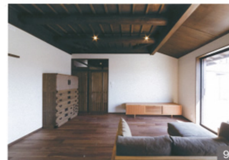
↑ 居間上部の2階床組にも丸木の梁が使われていた。これまで隠れていた木軸組を見せることで、材質感のある空間になった。
