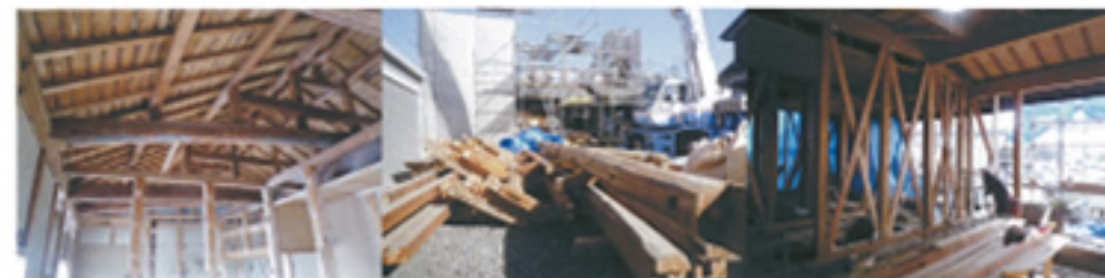
↑ 解体中の母屋の2階 屋根を下げるため、小屋裏を取り外す。
