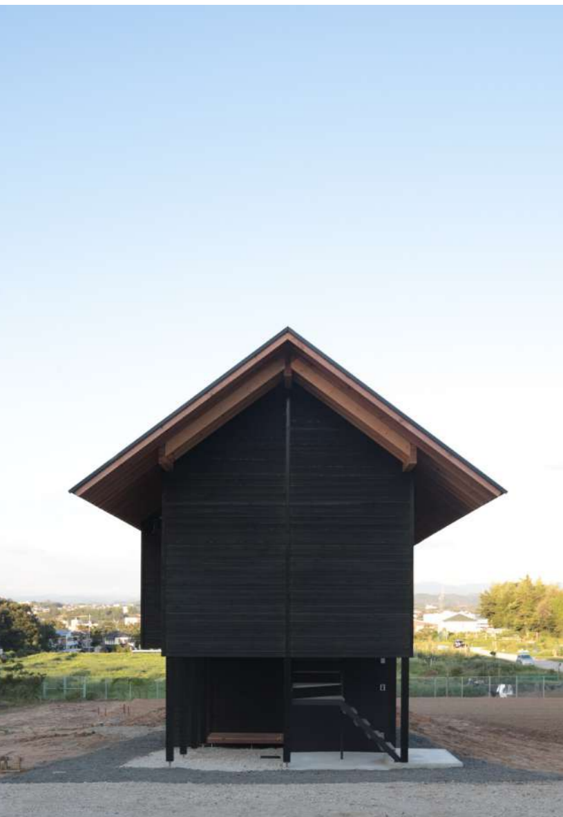
西側全景。広大な敷地に開口と高さを抑えて構える。
