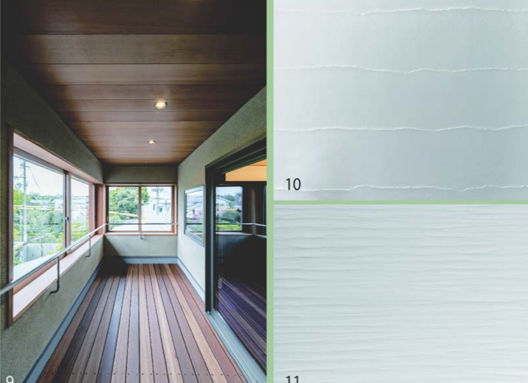
8: 子世帯のLDKは現代的な白を基調とした空間とした。 9: サンプルームは壁で覆って半屋外とし、外観に木製建具の風合いを出した。 10: ROOM3の漆喰壁は重ね塗り。様々なパターンを各部屋に施している。 11: LDKの一面に塗った横引き仕上げの漆喰壁。
