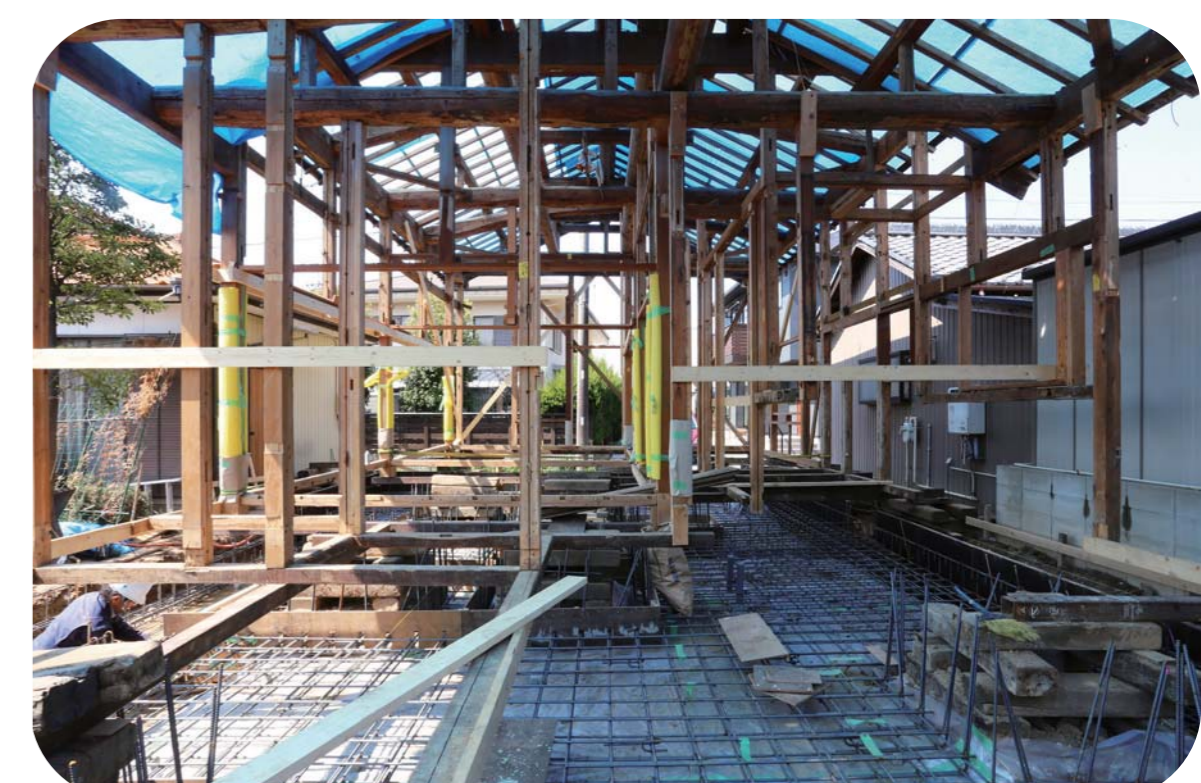
3. 揚家をしながら、現行基準に合致する基礎を新設
