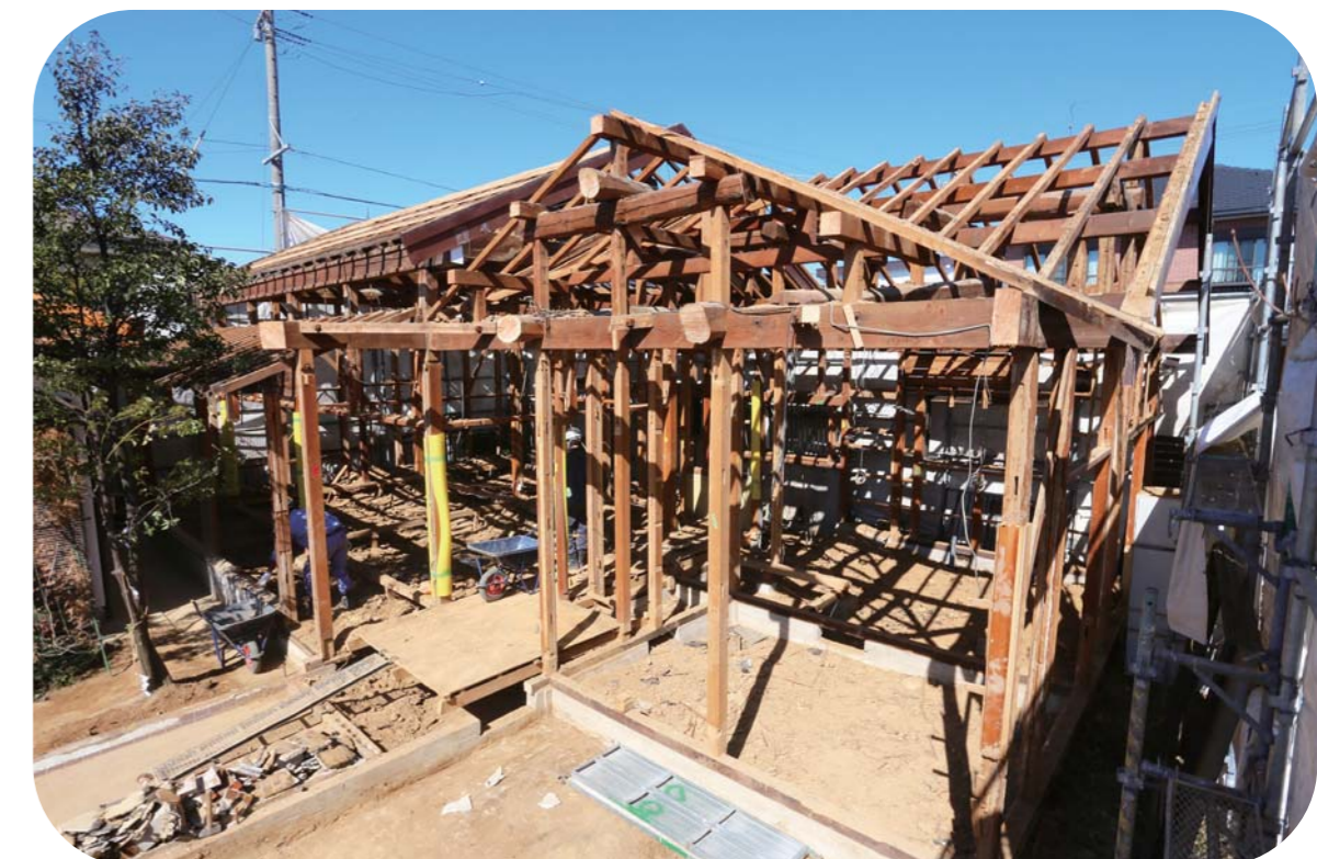
2. 部分解体：一度スケルトンにし、部材の確認と寸法調査
