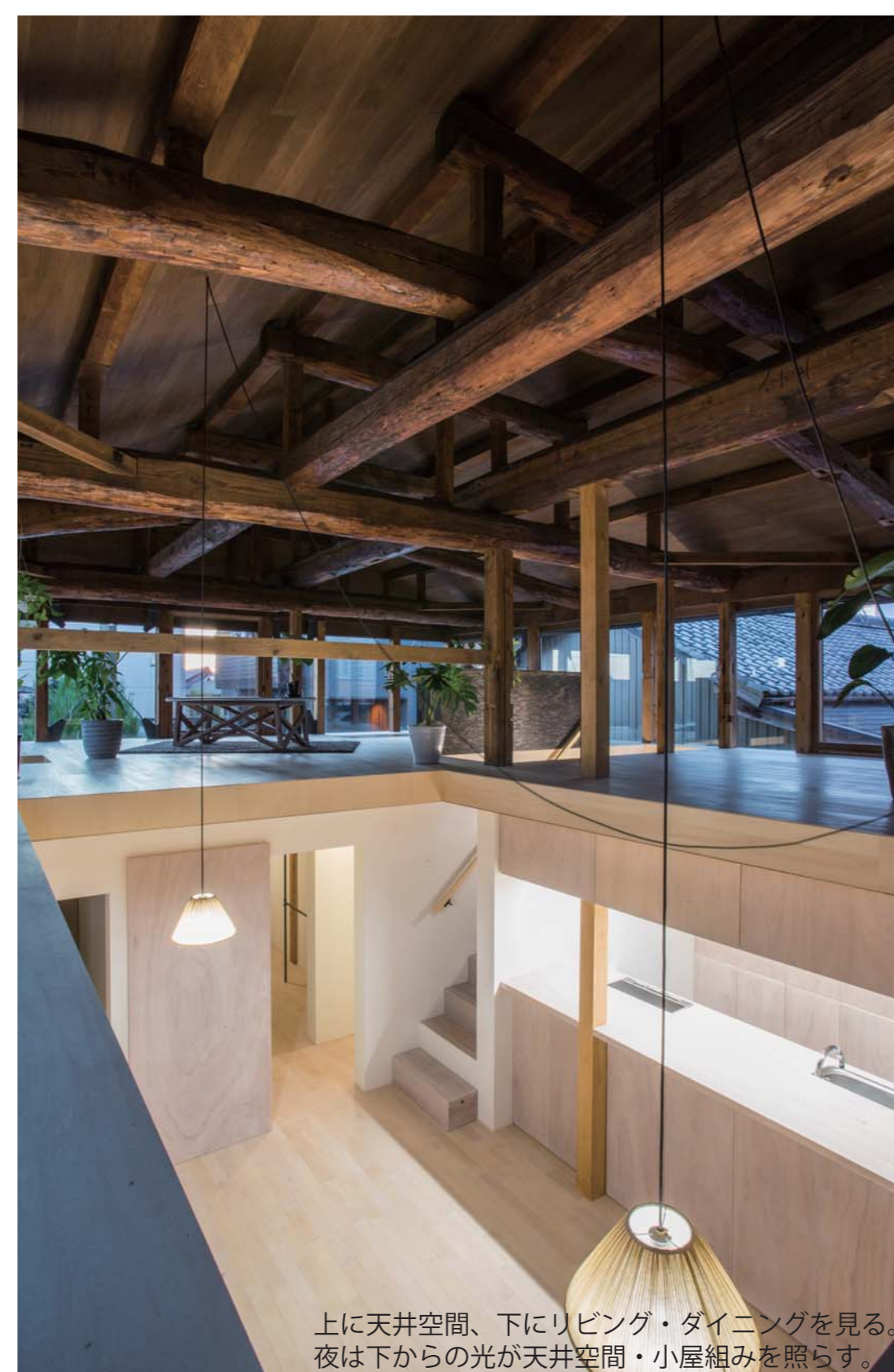
天井空間を見る。梁の高さはFL+1.5mほどで、座ると視線が通り、立つと梁が視線を遮る。
