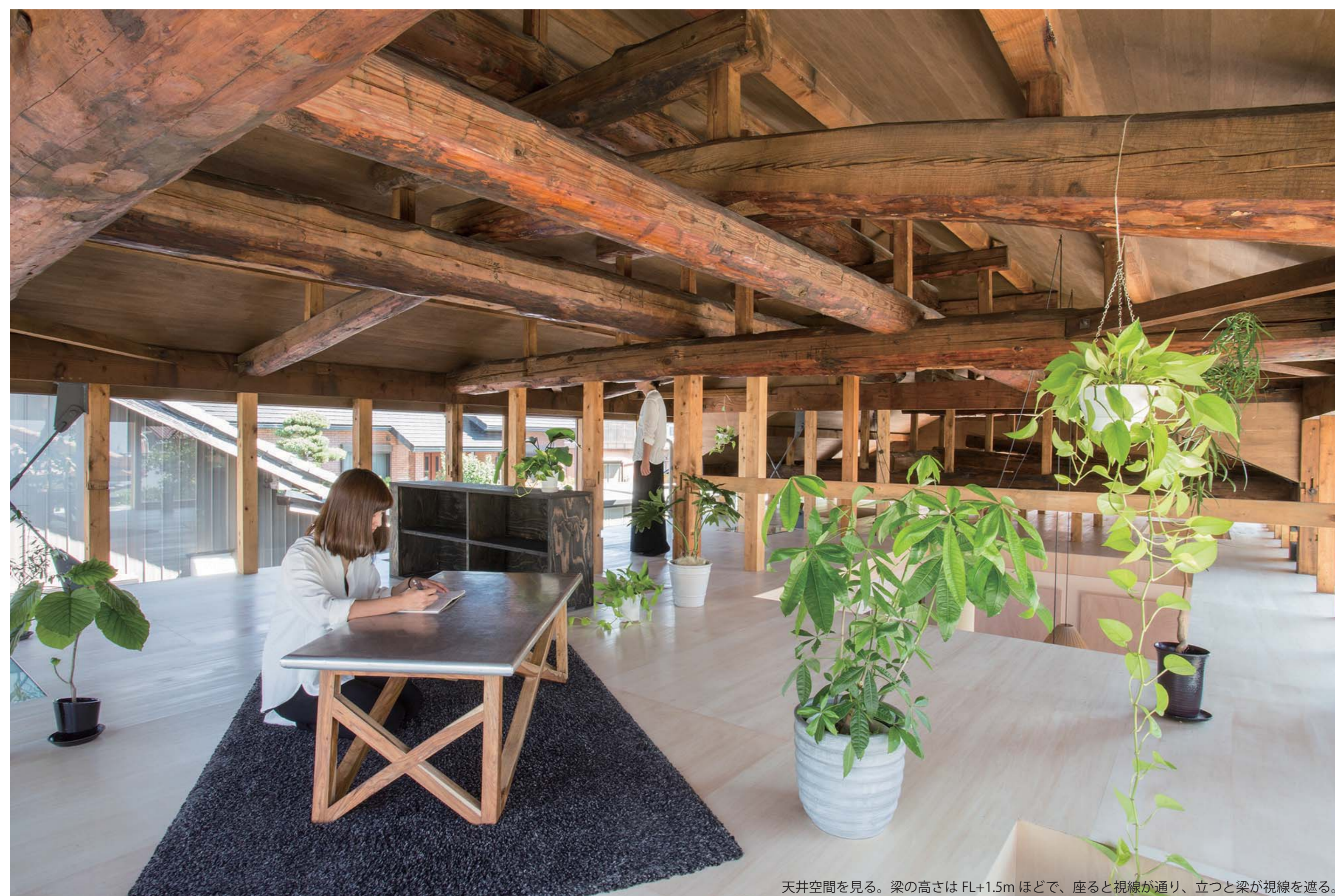
天井空間を見る。梁の高さはFL+1.5mほどで、座ると視線が通り、立つと梁が視線を遮る。
