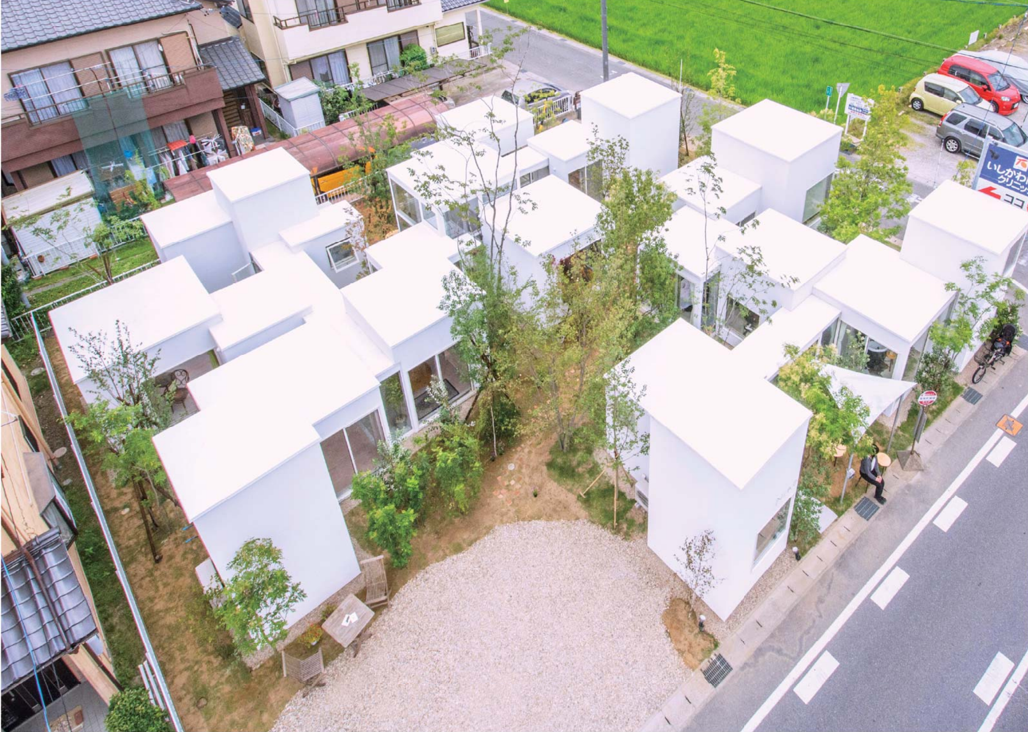
竿敷地に建て込んだ住宅地、田んぼや駐車場などの大きな空間、大きさや密度間がまちまちな場所である
