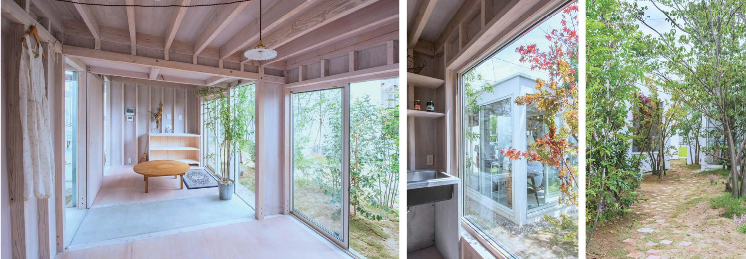
みんなの部屋からリビングを見る 間柱は45×90mm角のものを278〜351mmピッチで調節している。 キッチンから美容院を見る。 敷地の中央を散歩道が抜ける。
