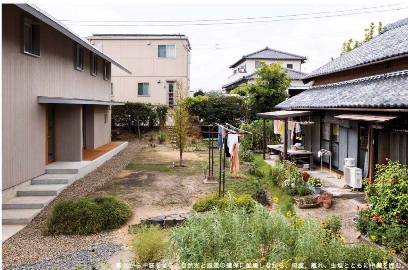
南から中庭を望む。自然光と風通しの確保に配慮しながら、母屋、離れ、中庭とともに心地よく利用。
