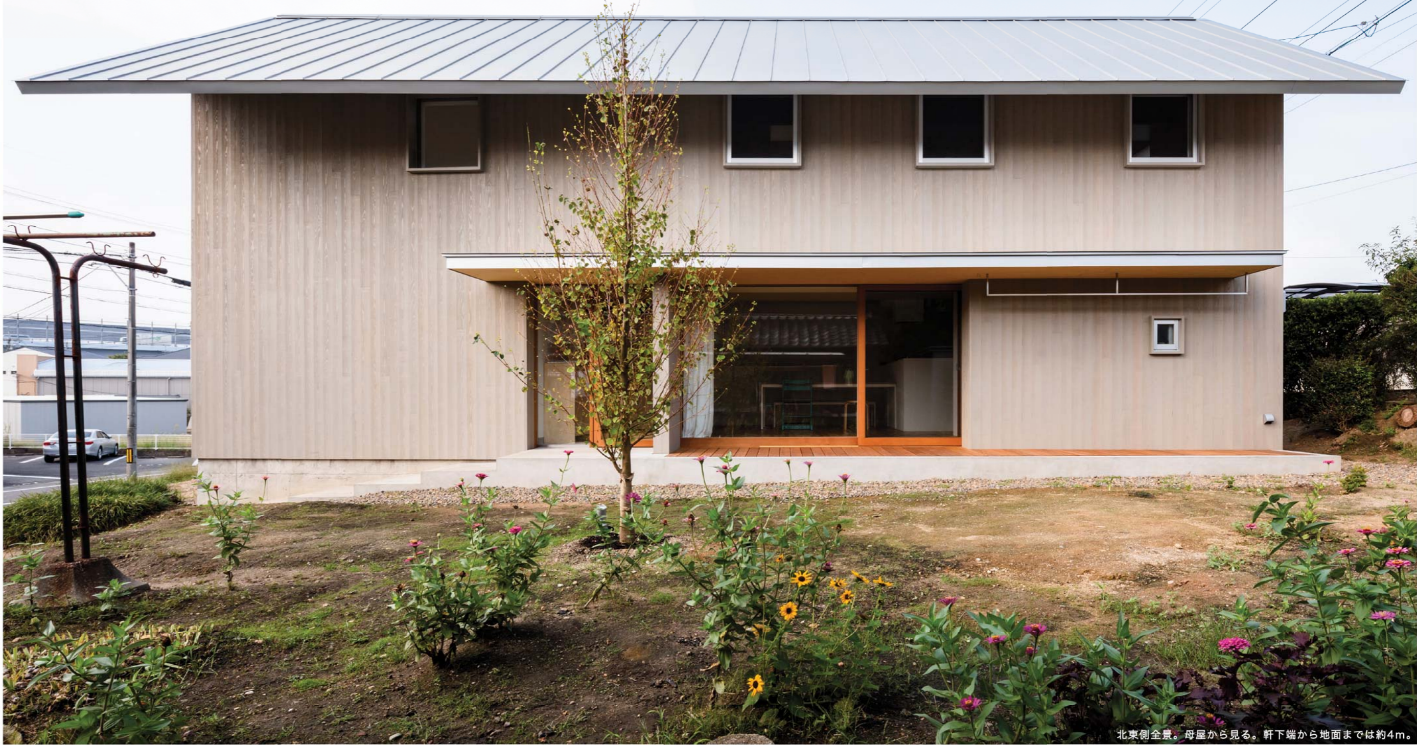
北東側全景。母屋から見る。軒下端から地面までは約4m。
