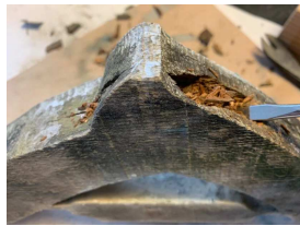
不良部の切除
