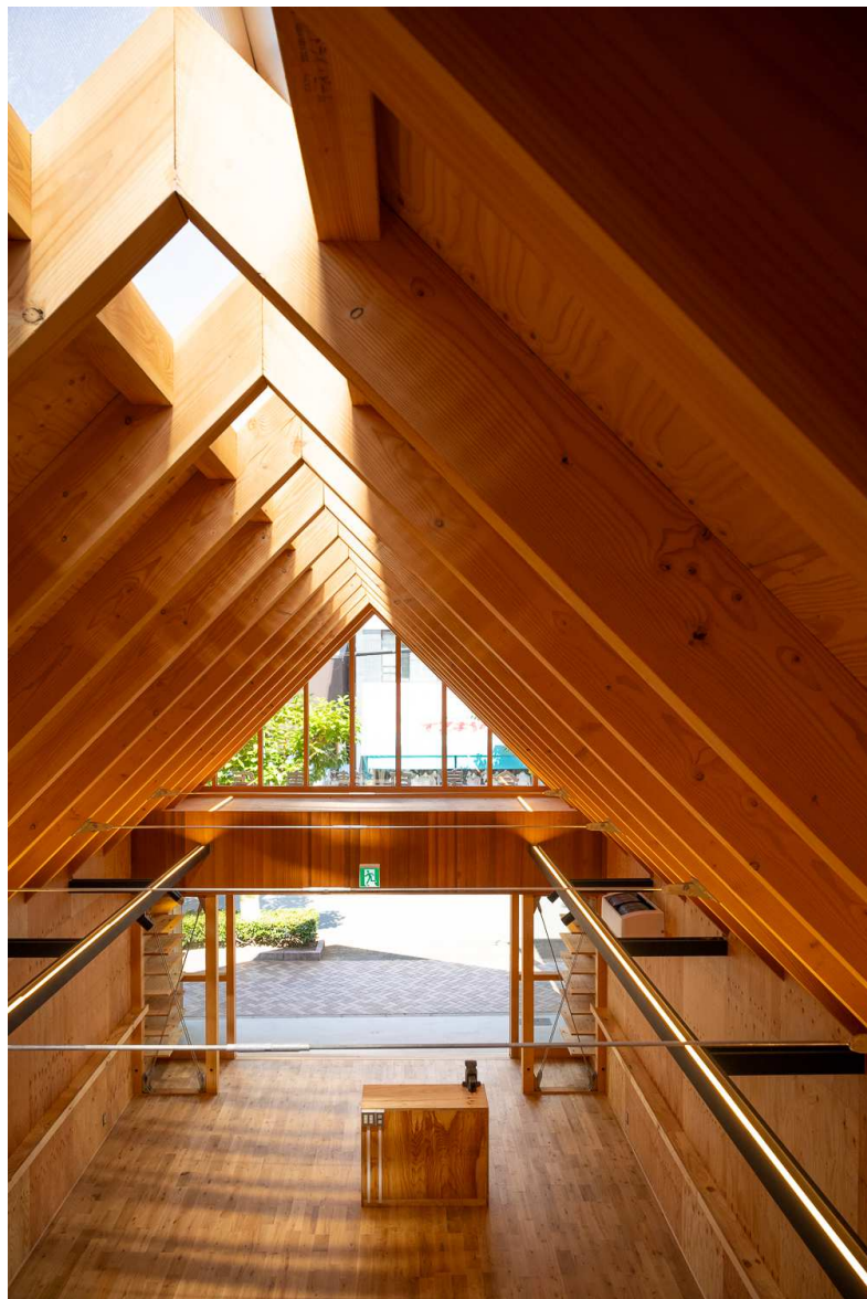
物置から前面道路側を見る。棟部にトップライトを設けている
