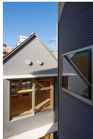
住居棟2階から店舗棟を見る
