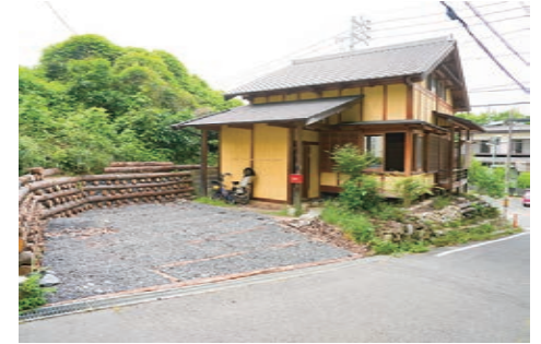
雨落ちと栗石の路盤と猪垣
