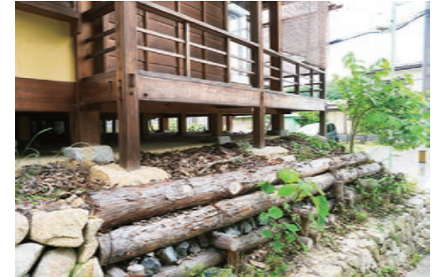
栗石と木杭による土留め工事
