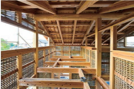
金物を使わない木組みの構造
