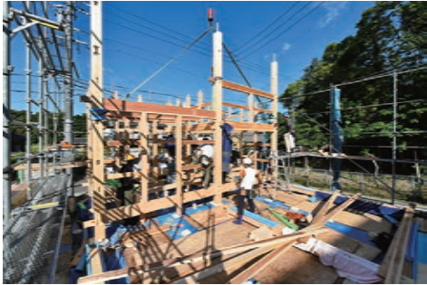
石場建ての建前風景
