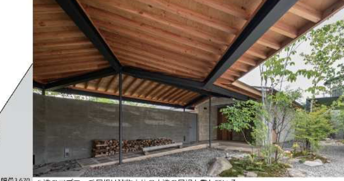
5造のアプローチ屋根は建物本体の木造の屋根と重なる。黒垢の鉄骨柱70φからアプローチ屋根を片持ちとし、米松雲木で人を招き入れる形とした。壁と屋根の隙間からは庭の緑が切り取られる。
