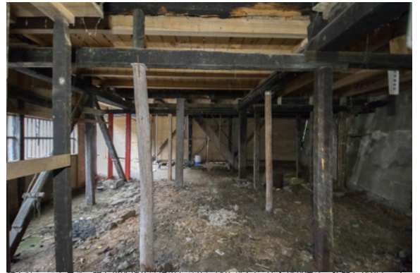
既存時の1Fを見る。既存構造躯体は場当たり的に補修がされ、接合部が極めて脆弱な状態であった。
