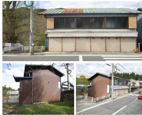
既存時の外観を見る。様々な年代に手に加えられ、継ぎ接ぎな状態であった。
