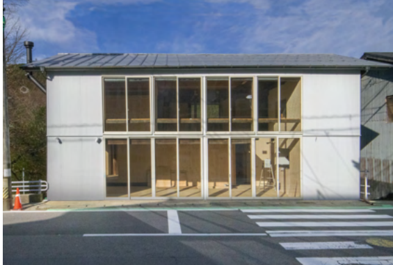
南面から見る。元々隠されていた構造躯体を露わにし、その外側に波板とアルミサッシで包みこんだ / 旧商店街から建物を見る。道と川辺の2つのレベルに引き違いサッシを設けた。
