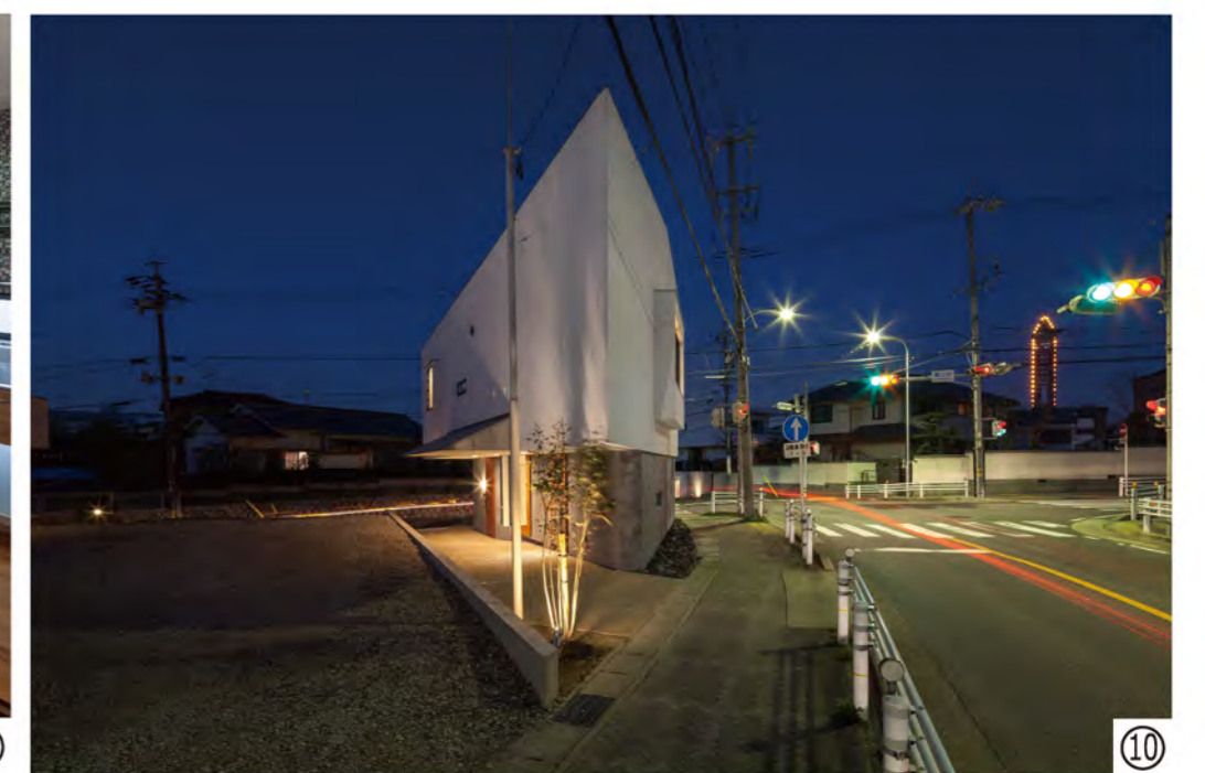
南面より夜景を見る ⑩
