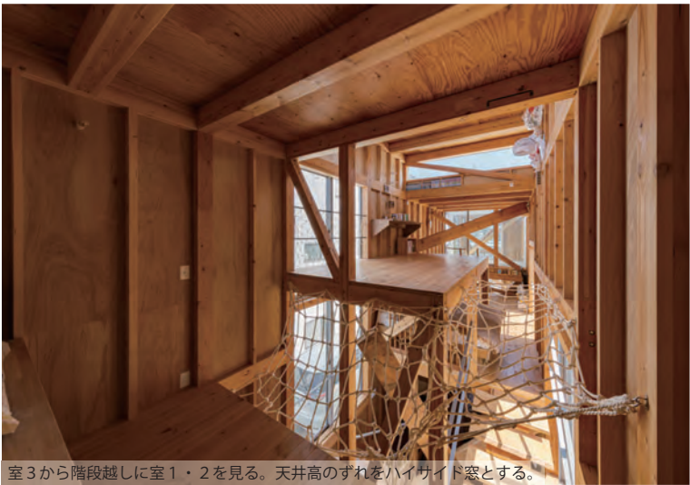
室3から階段越しに室1・2を見る。天井高のずれをハイガイド窓とする。
