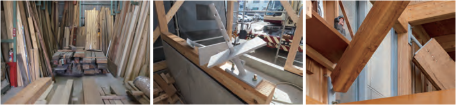
左：計画前の木材倉庫の様子。整理されているわけではなく、手に入れた順に詰め込まれた状態だった。 中：ストック木材を使用したプレースの端部金物。プレース端部を座標から検出しすべて異なる角度を決定して制作。 右：ストック木材設置後の端部金物とストック木材の関係。ストック木材がそのままの形で見えるように計画している。
