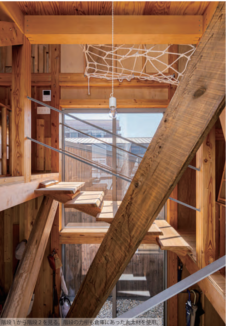
階段1から階段2を見る。階段の力桁も倉庫にあった丸太材を使用。
