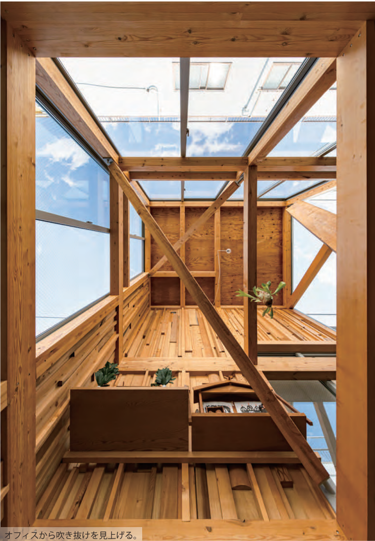
オフィスから吹き抜けを見上げる。
