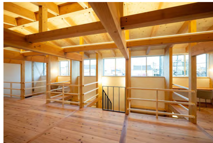
2階東側を見る：連窓と吹抜け
