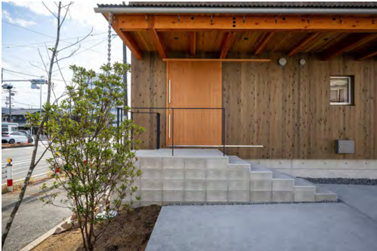
アプローチ：CP型枠を積んだ階段は本体と縁を切ってある
