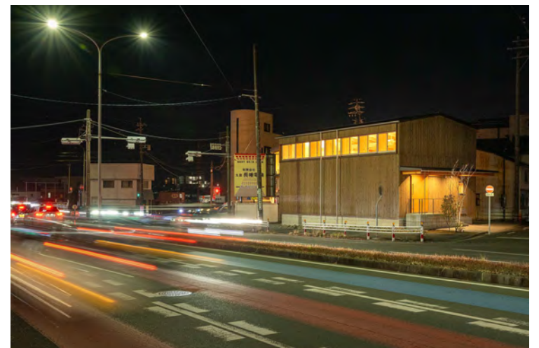
北東側夜景：連窓からあらわしの梁組が見える
