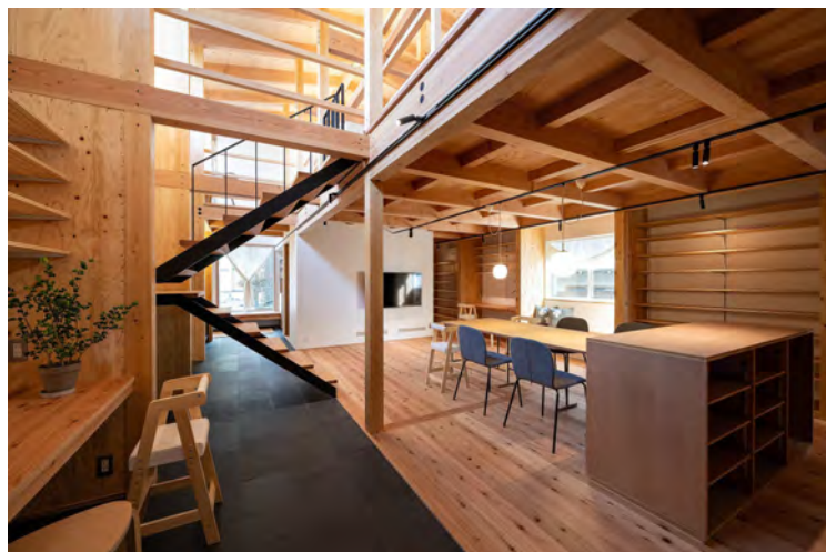
東西の壁面には1間ピッチで耐力壁のリブ
