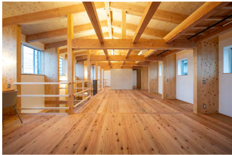
がらんどうの2階はロフトレベルで梁を配置
