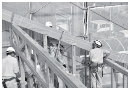
施工者の高い技術により精度の高い建て起こしが実現
