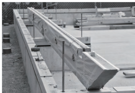
完成した合成梁
